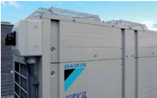
VRV de Recuperación de Calor
